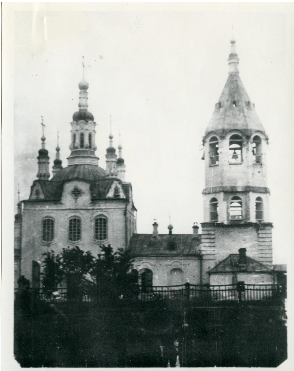
С. Тасеево. Богоявленская церковь с приделом св. Николая Чудотворца. Построена в 1804 году. Восстановлена и освящена после пожара в 1866 г.
